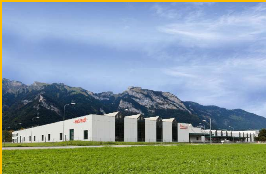
Pyropac AG, Sennwald (Kanton St. Gallen), Produktionsbetrieb für Weishaupt Heizsysteme
