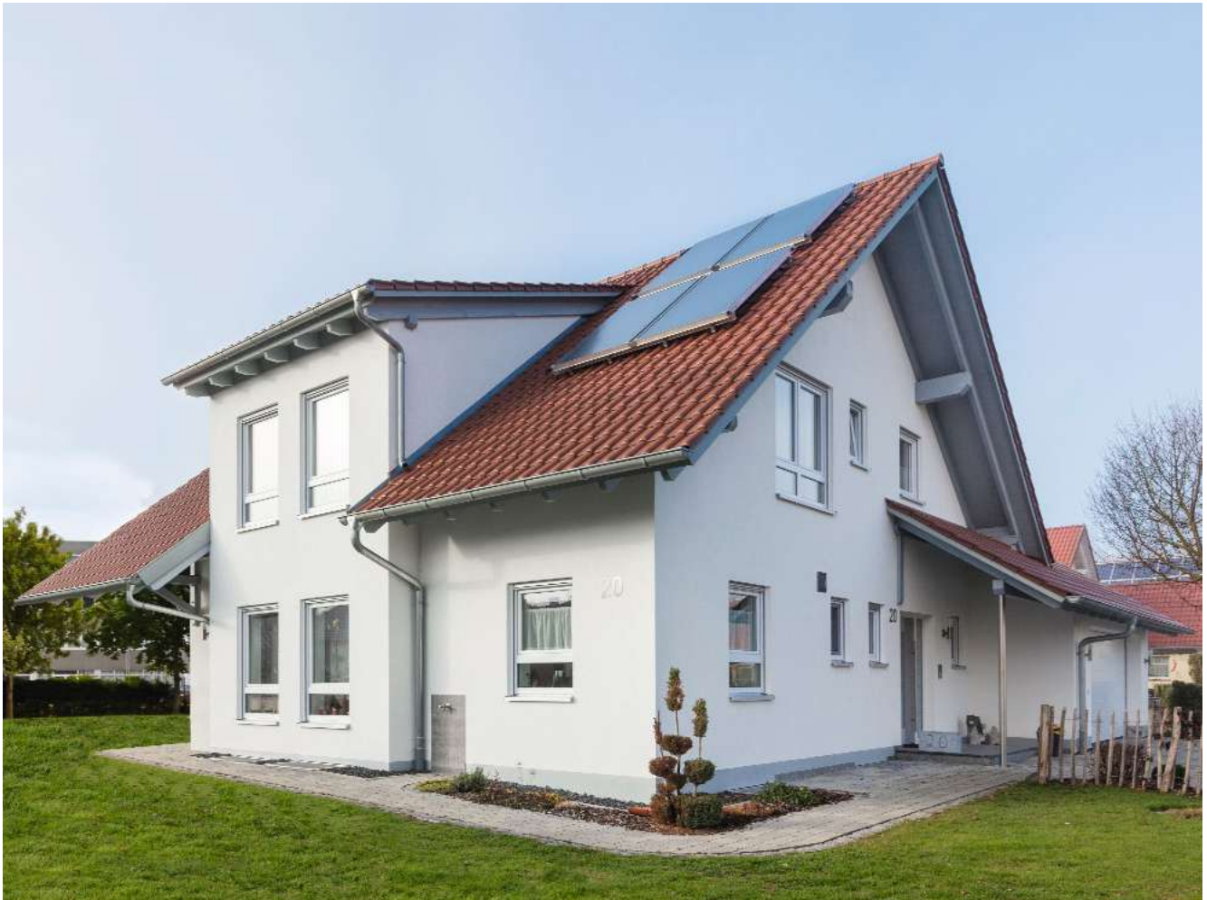
Kollektoranlage zur kombinierten Trinkwassererwärmung und Heizungsunterstützung
