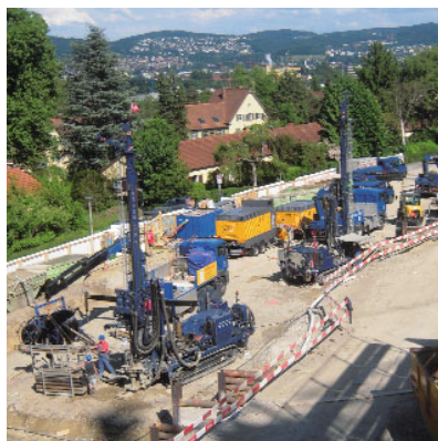
Bohrung eines Erdsondenfelds
